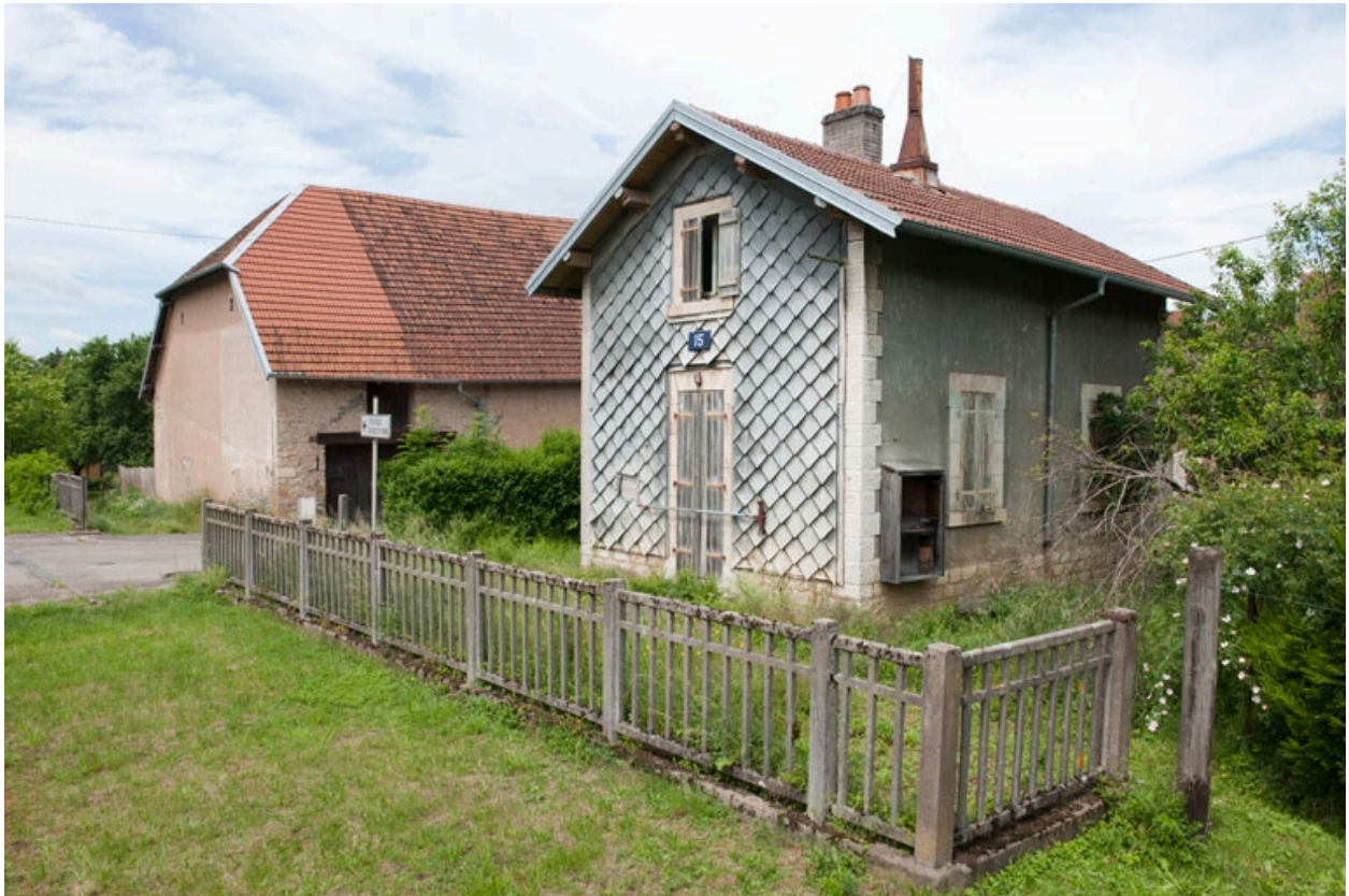
Maison de garde-barrière (cadastrée AK 125), rue du Pont.
