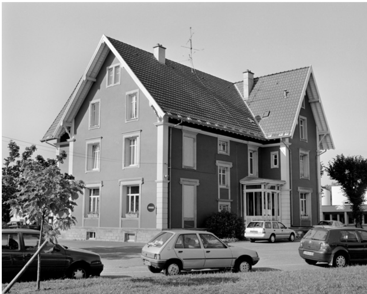
Le logement patronal depuis le nord.
