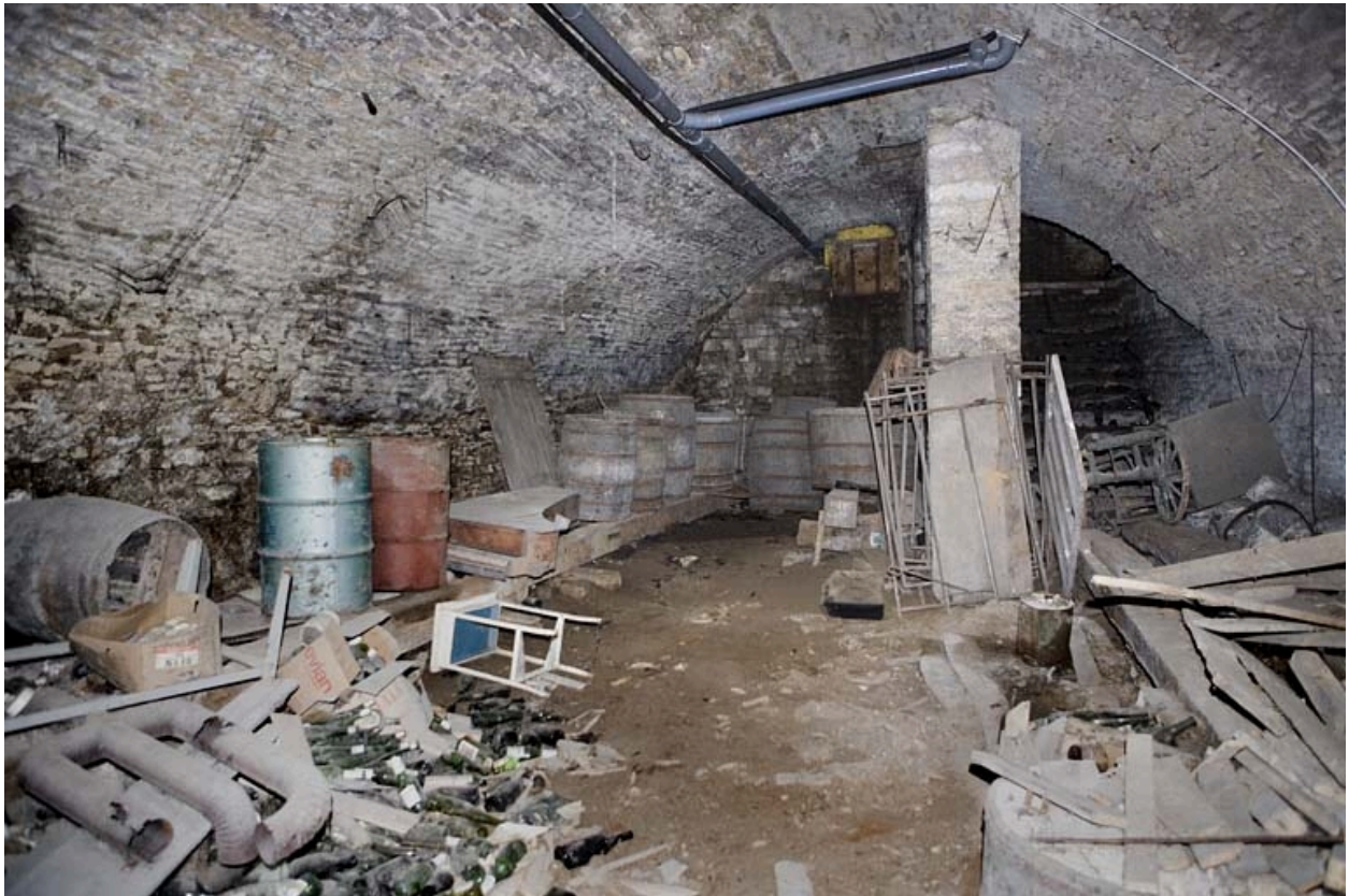
Intérieur, sous-sol : vue de la cave gauche, depuis l'entrée.
