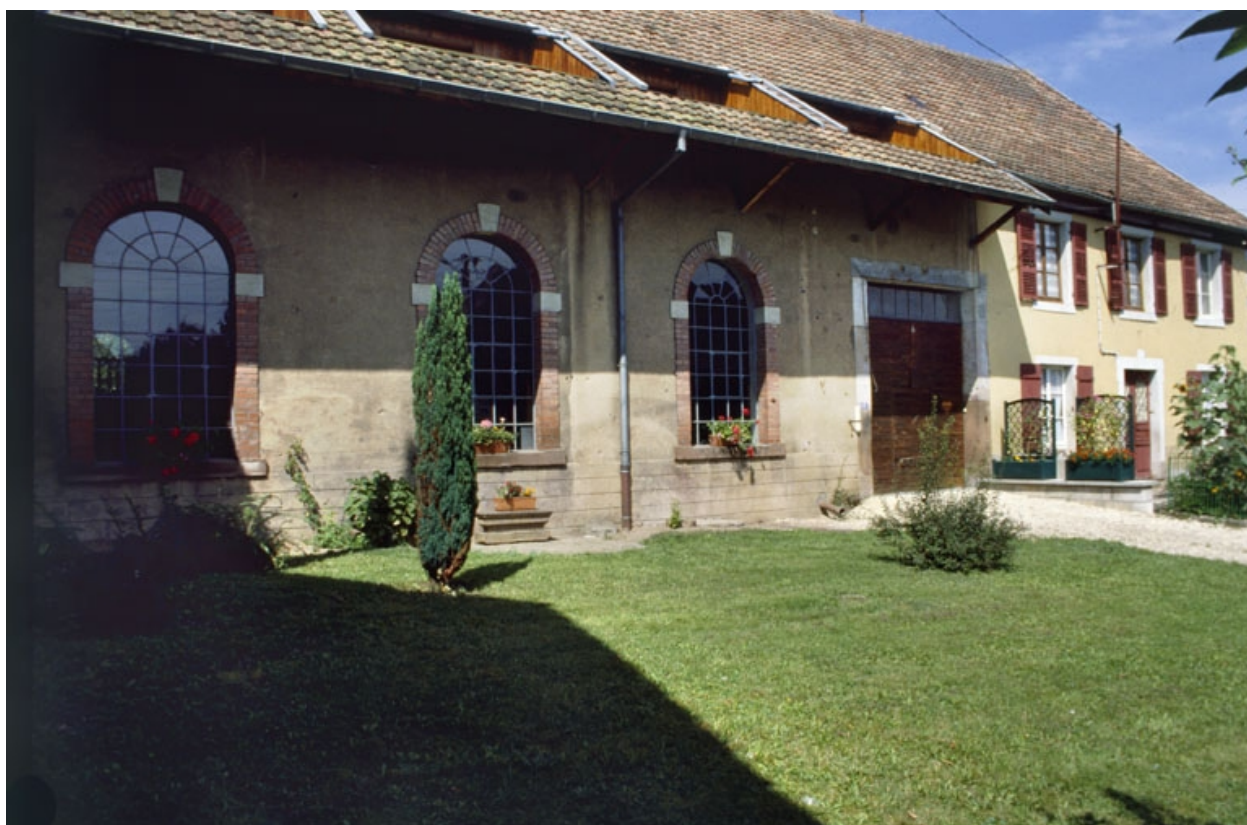
Façade de l'atelier mécanique.
