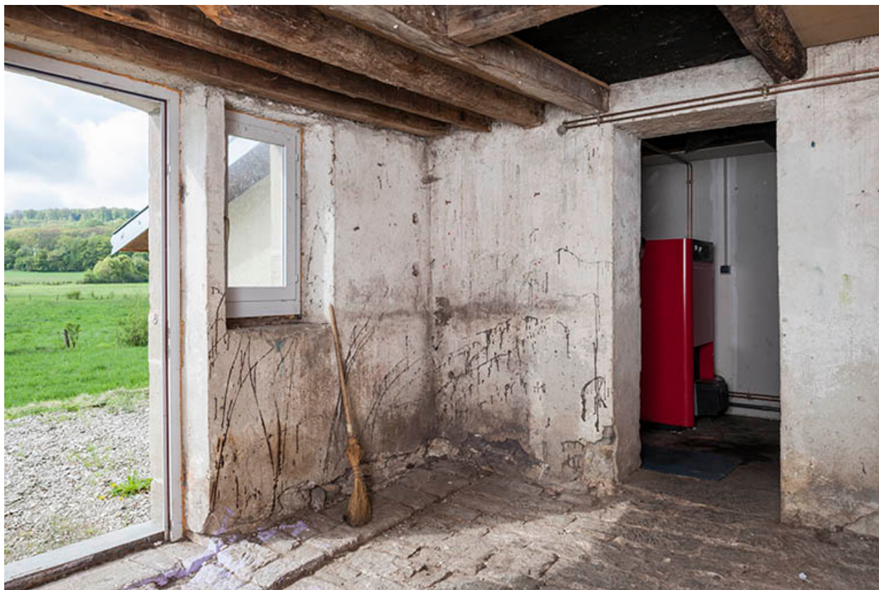
Cave en déblai.
