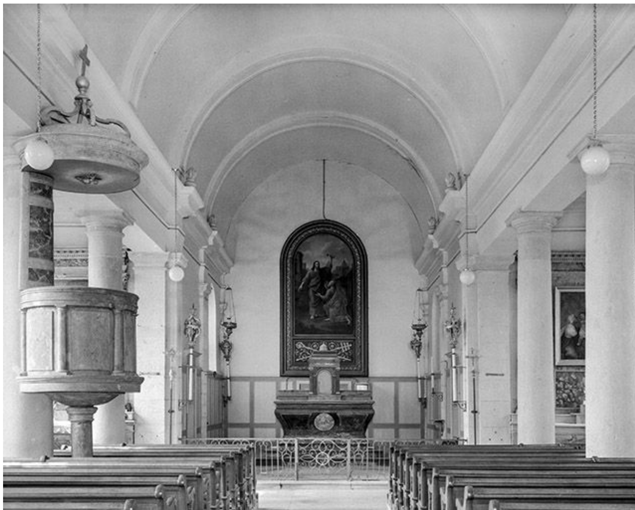
Intérieur : nef, vaisseau central et chœur.
