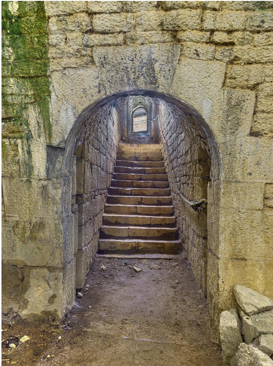
Escalier menant à la casemate du demi-bastion depuis l'intérieur du fort.
