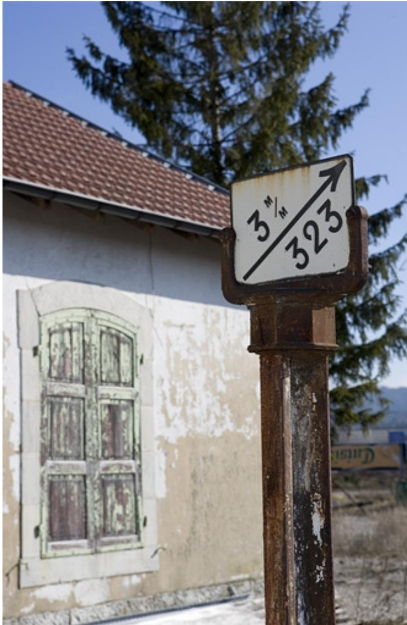
Face côté Andelot-en-Montagne. Le panneau signale que la voie est en rampe (pente ascendante) de 3 mm / m sur 323 m.
