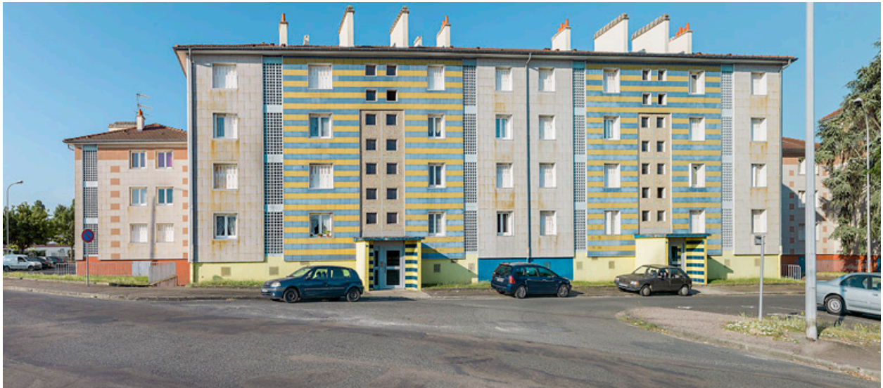
Bâtiment A, façade antérieure est.
