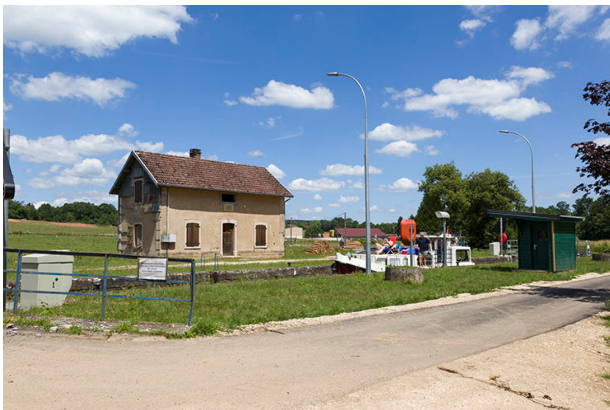
Le site d'écluse.
