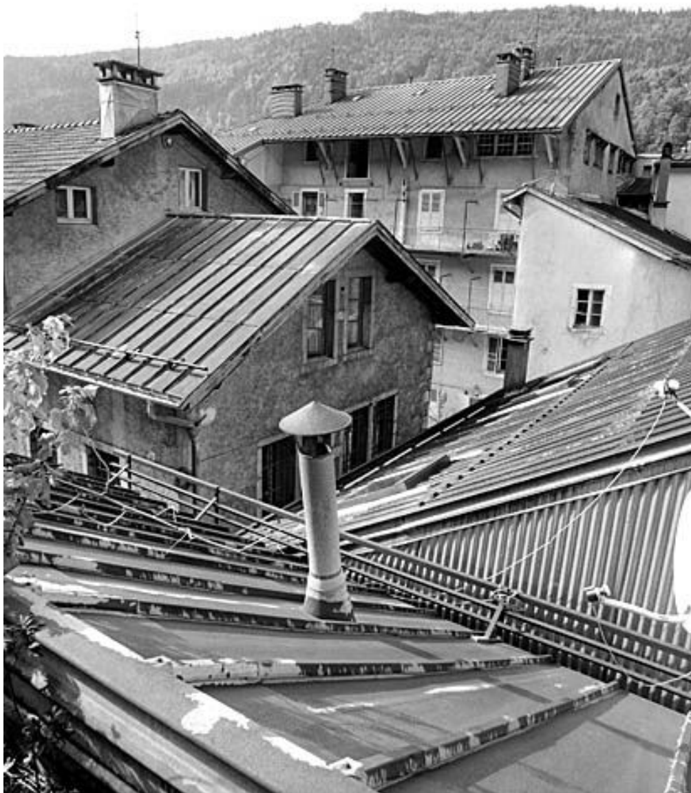
Toitures des bâtiments est et nord-est.
