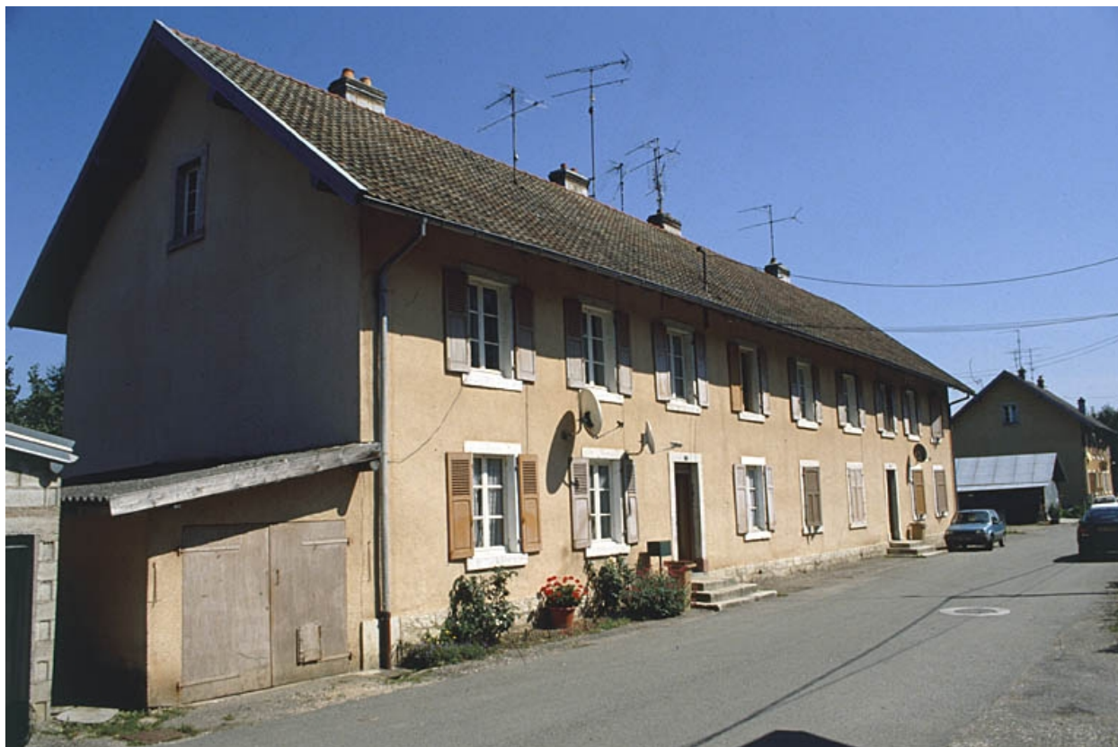
Logement ouvrier collectif.
