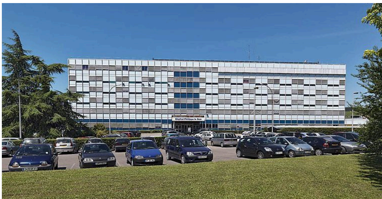
Bâtiment principal, façade.
