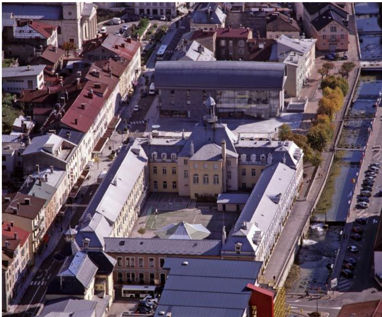
Vue d'ensemble plongeante, depuis le nord.
