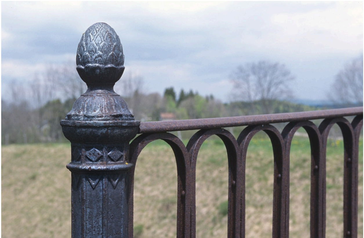
Motif d'amortissement d'un potelet du garde-corps.
