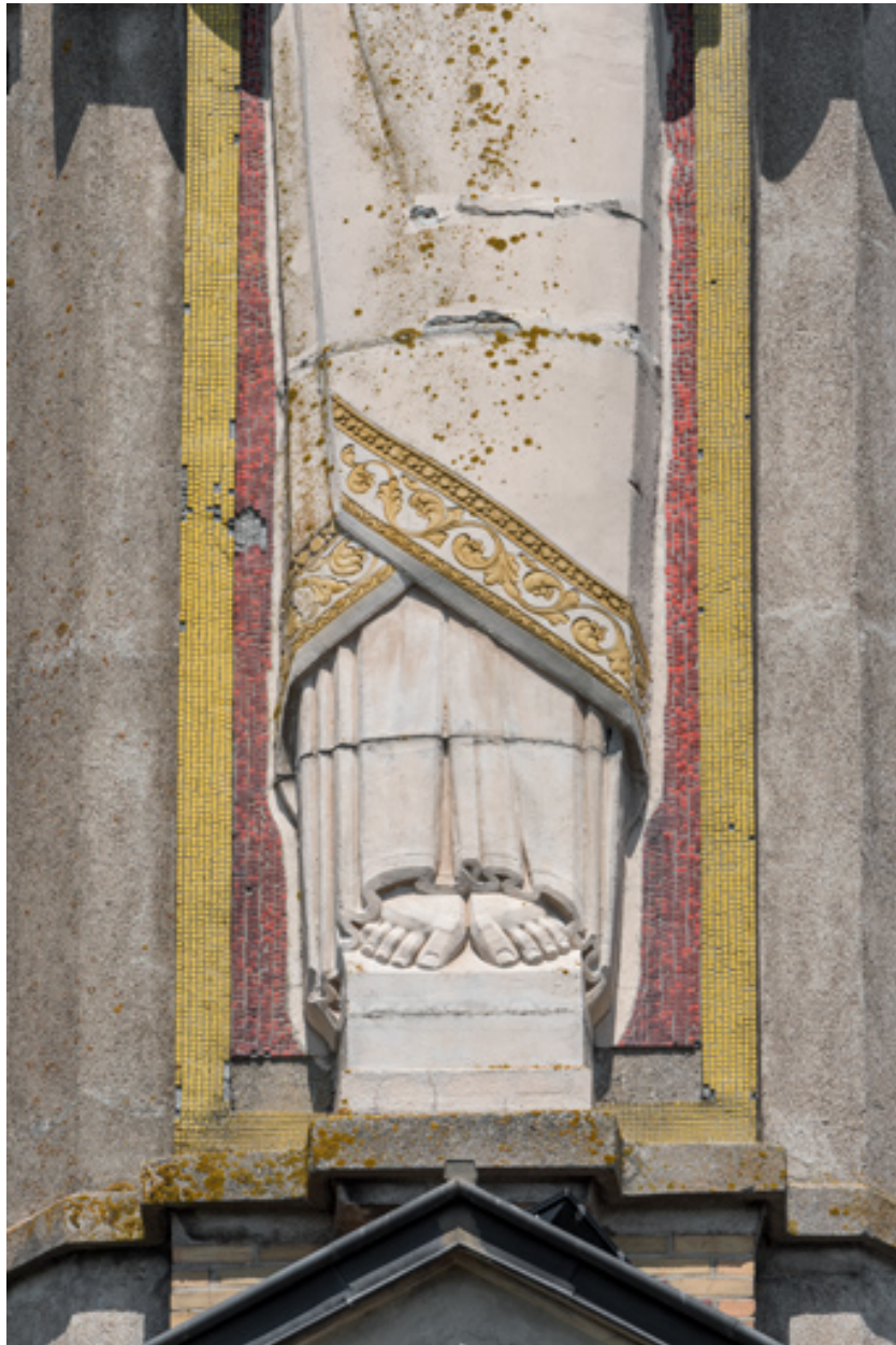
Bas-relief du clocher. Détail de la partie inférieure.
