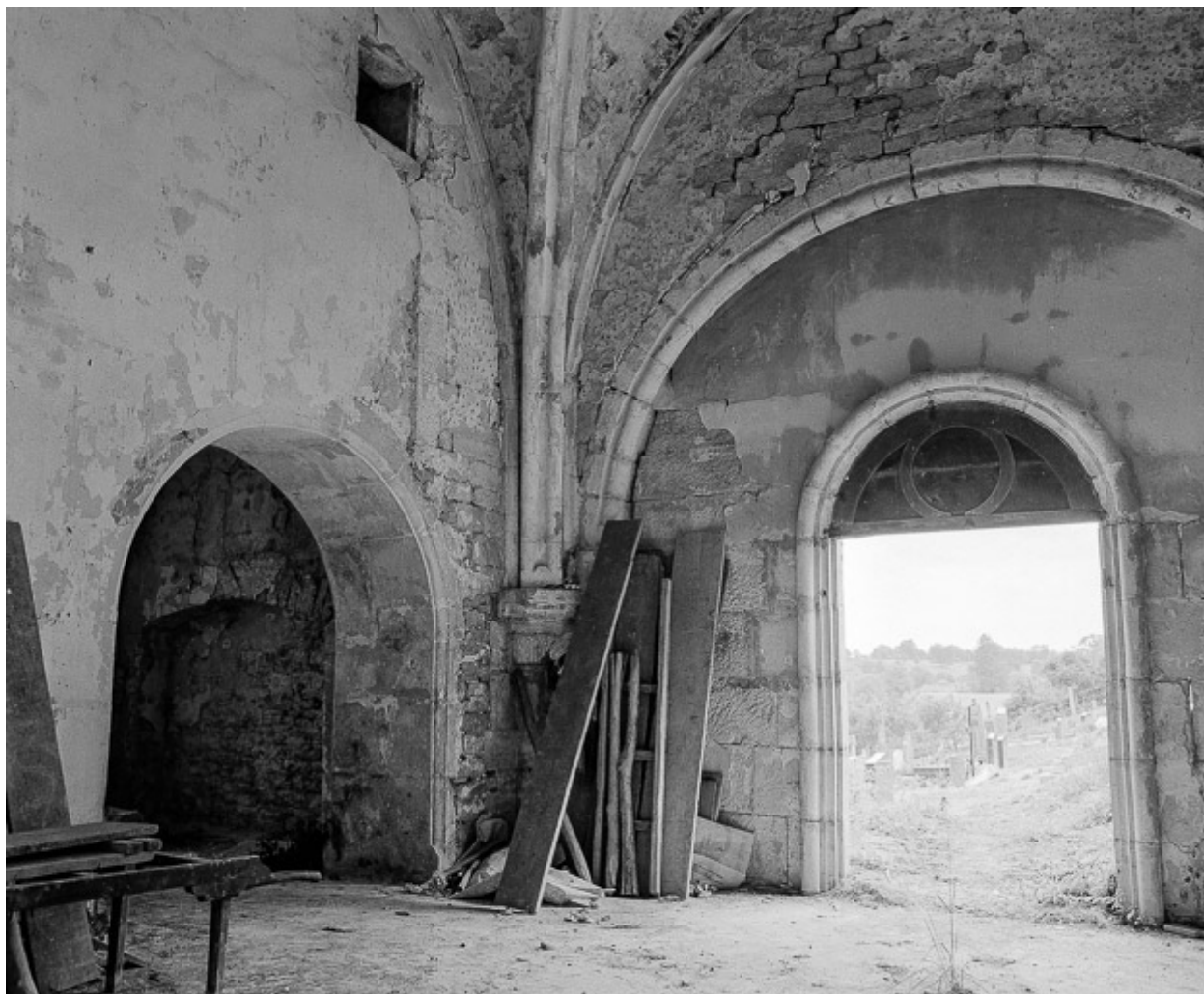
Intérieur : mur antérieur et latéral droit.
