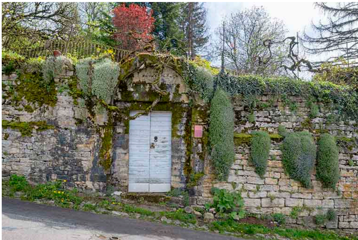
Porte d'entrée rue des Chambenoz.
