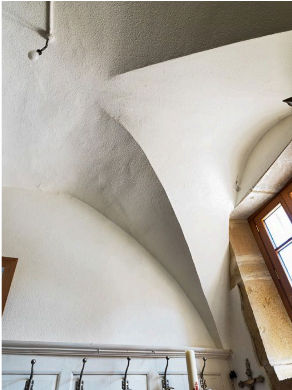
Voûte de la sacristie.
