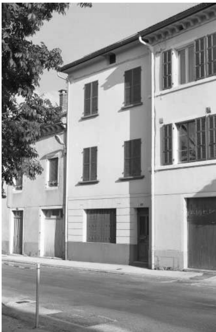
Façade antérieure du logement patronal (28, Grande Rue).
