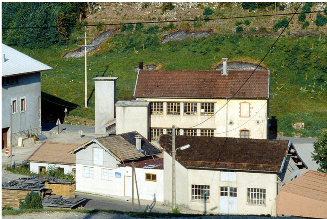
Façade postérieure vue de trois quarts droite.
