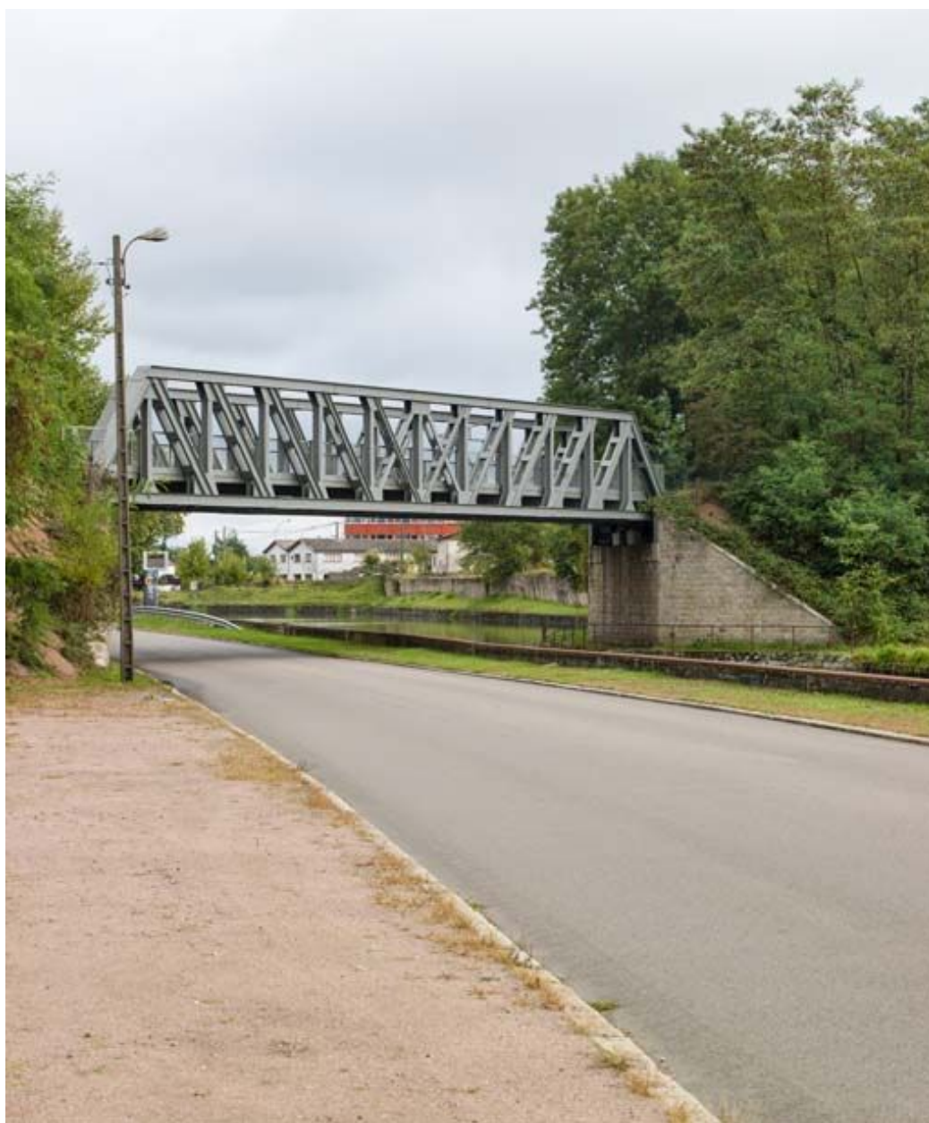
Vue d'ensemble du pont.
