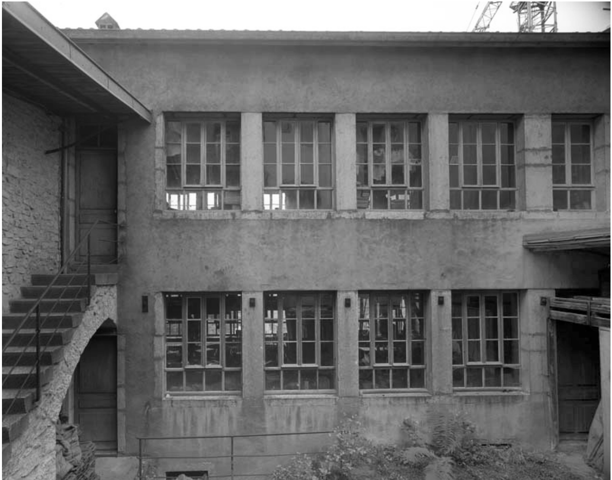
Façade antérieure de l'usine.
