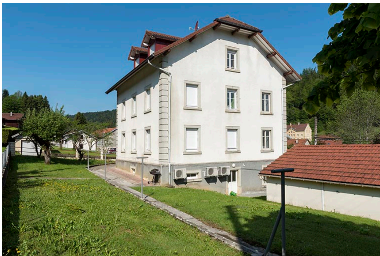
Façades postérieure et latérale droite.
