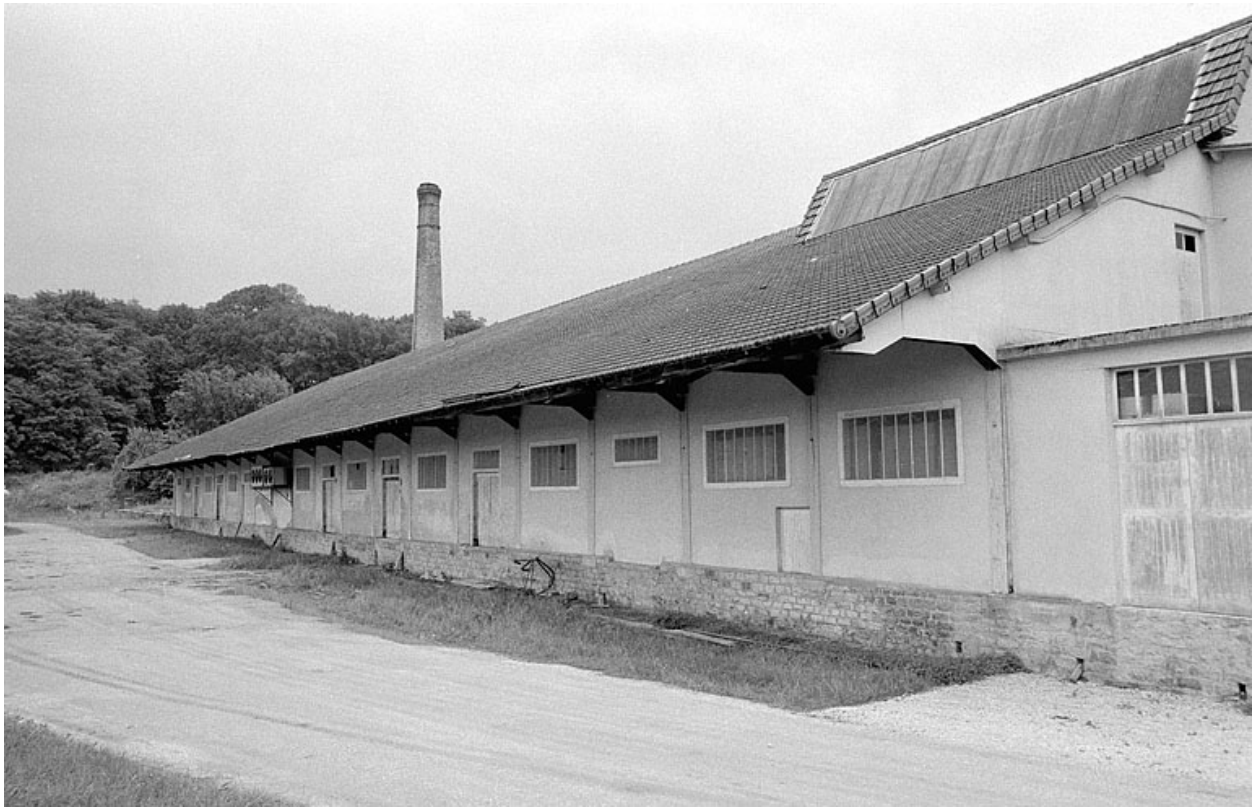
Magasin industriel depuis le nord-ouest en 1980.
