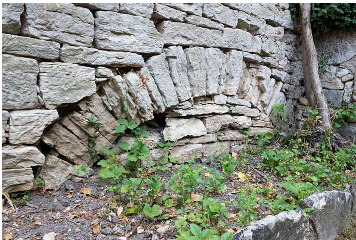
Détail de la maçonnerie d'une voûte.
