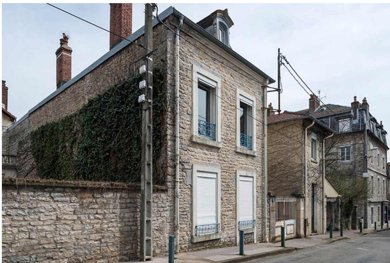
Entrée rue du Château-Rose.
