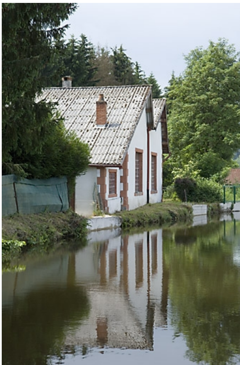
Atelier de réparation sur le bief d'amenée.
