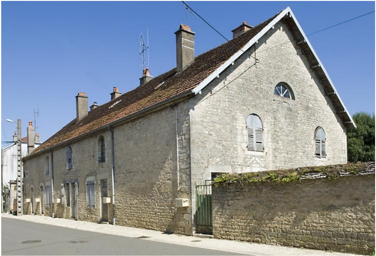
Logement ouvrier depuis l'ouest.
