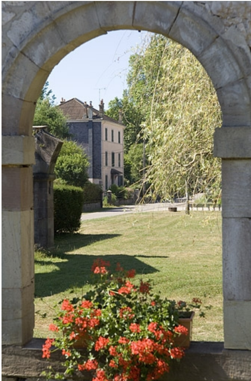
Mur nord de l'atelier de fabrication. Détail d'une baie.
