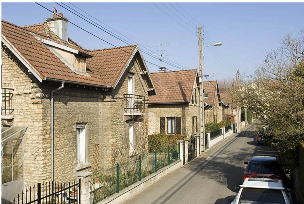
Façades antérieures sur la rue des Fleurs.
