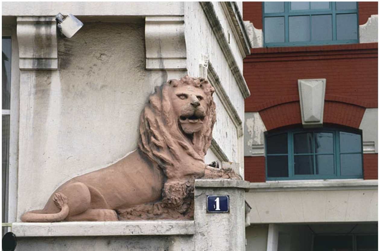
Détail du lion ornant l'entrée de l'usine.
