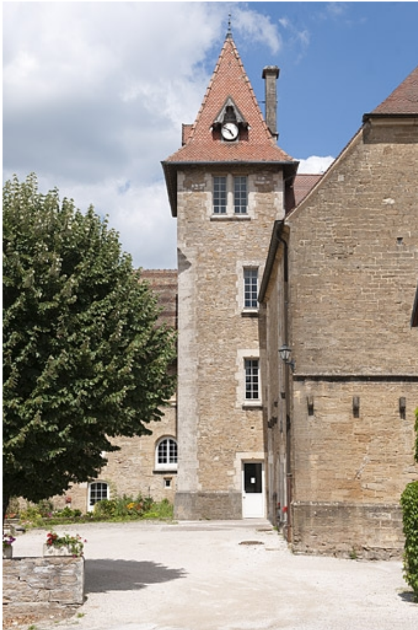
Bâtiment (C), vue de la tour d'escalier.
