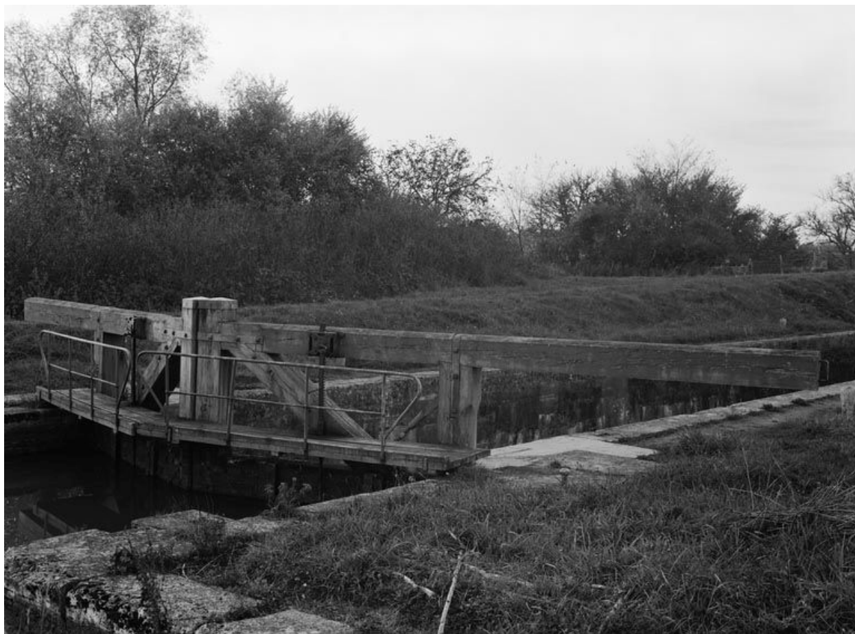
Portes en bois de l'écluse.
