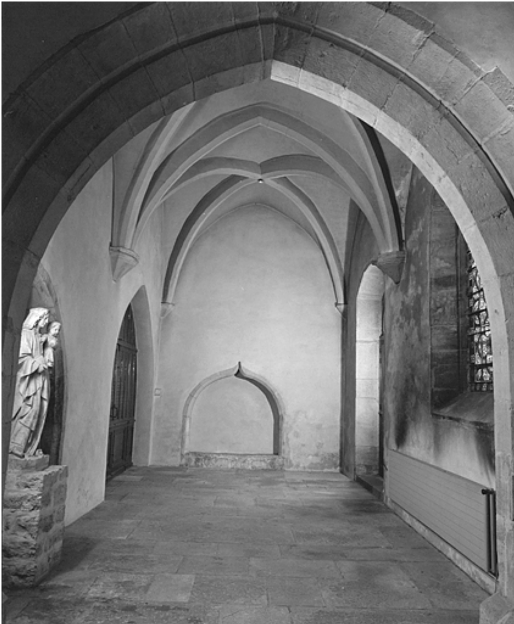
Eglise, quatrième chapelle gauche, vue depuis l'est.
