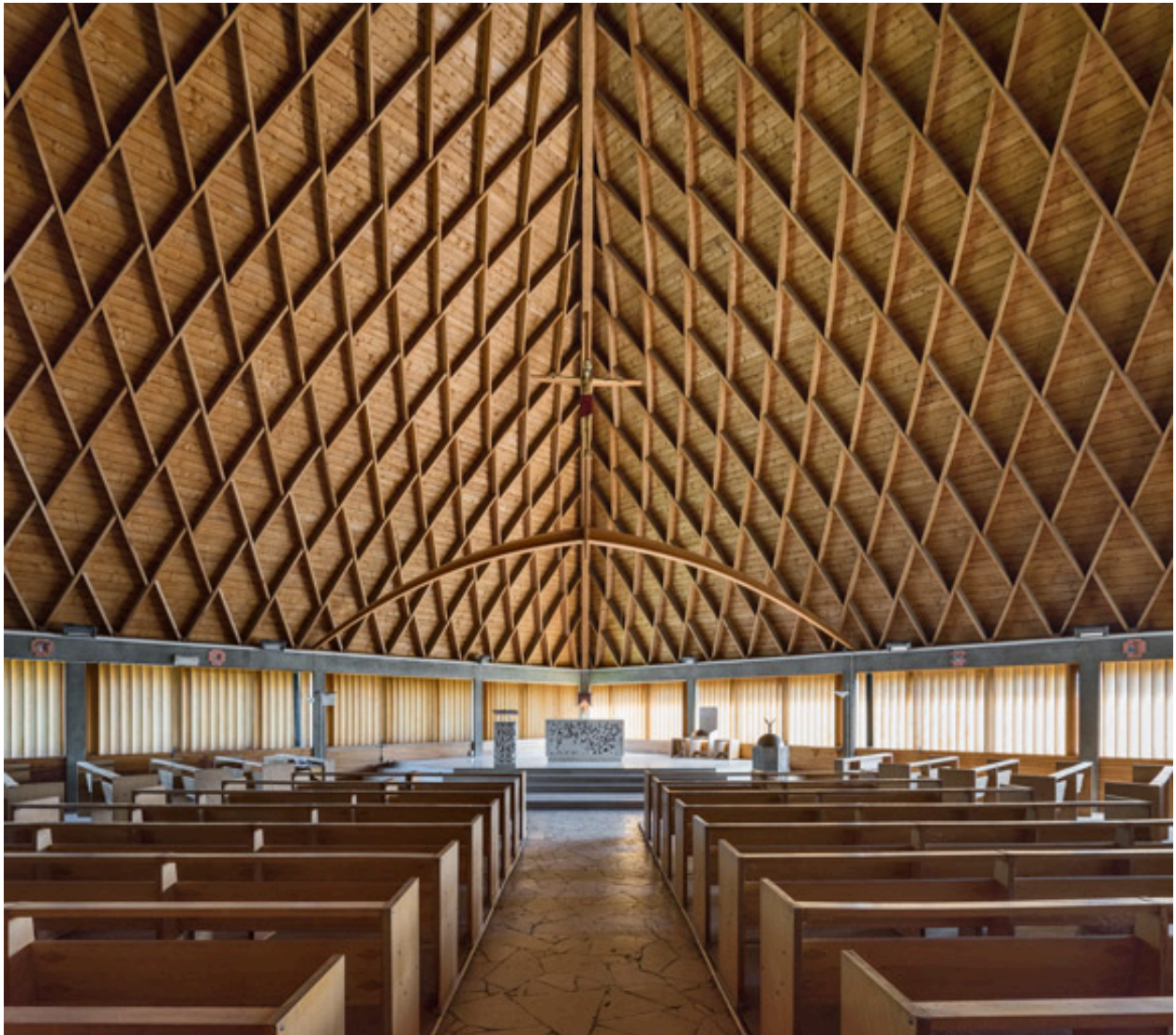
Chœur. Vue depuis l'allée centrale.
