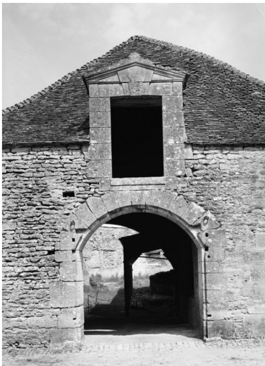
Entrée du bâtiment de la forge d'affinerie, élévation sud.
