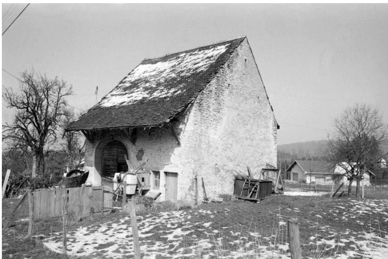
Edifice agricole à Montbouton.
