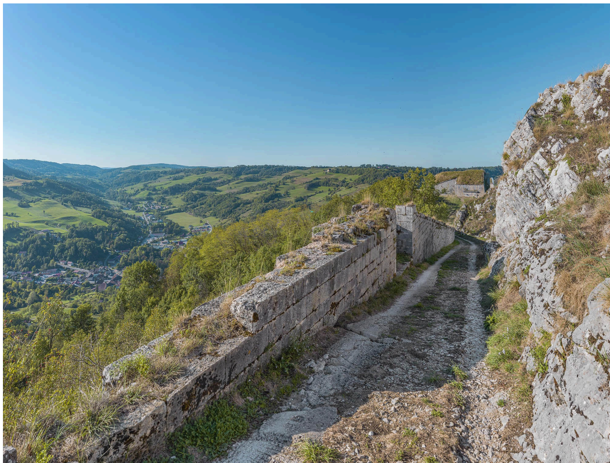
Chemin couvert reliant la redoute de Grelimbach à l'enceinte principale du fort.
