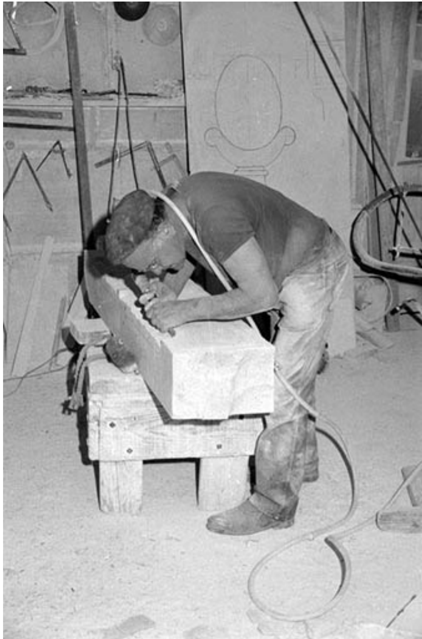
Taille de la pierre au burin pneumatique (J. Faccenda).
