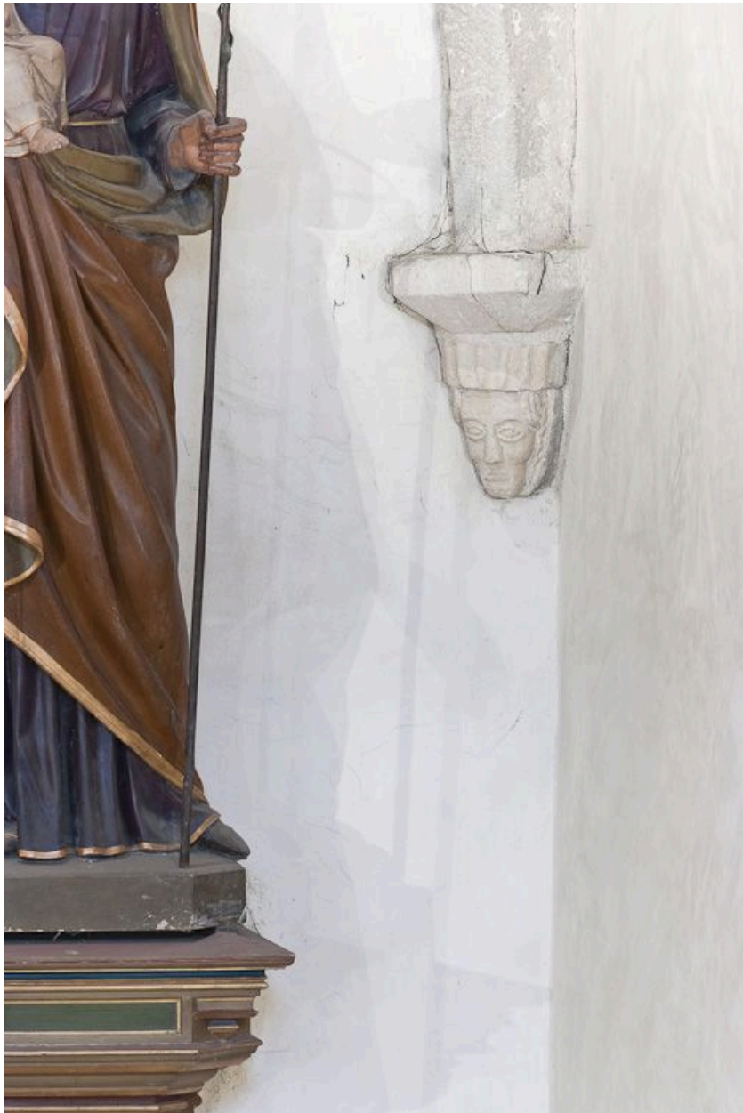
Culot postérieur droit de la troisième travée de la nef.
