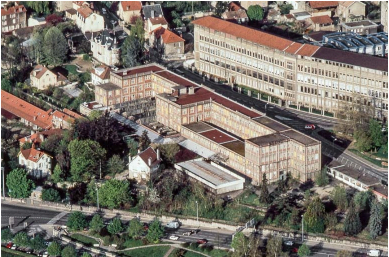
Vue aérienne de l'usine, depuis l'est.
