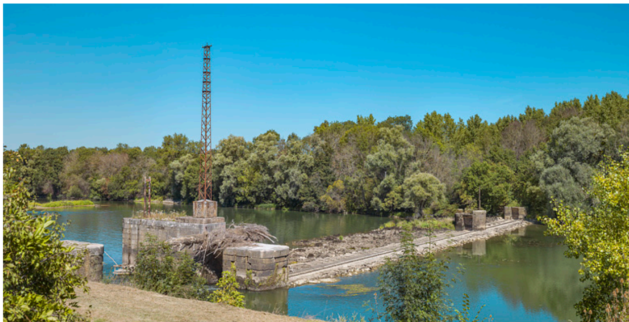
Vue d'ensemble du barrage, avec à gauche le pertuis, en 2019.
