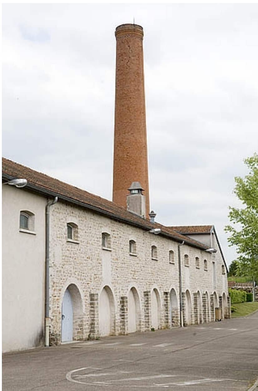
Façade nord vue de trois quarts gauche.
