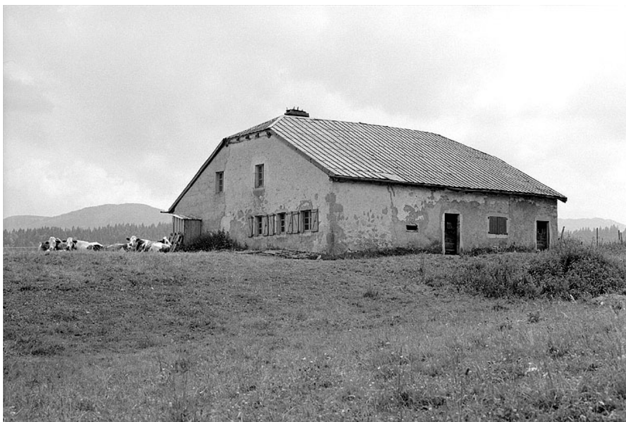
Façade postérieure et face droite.
