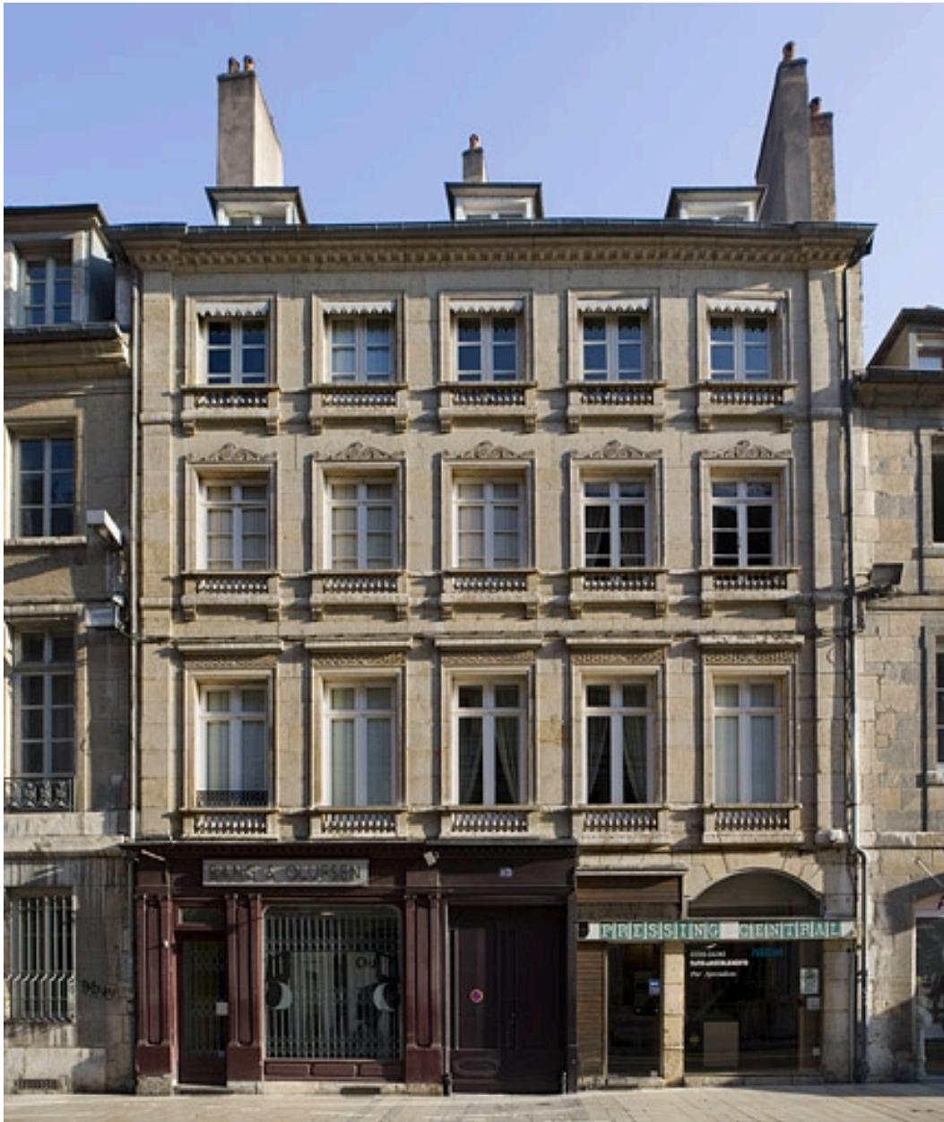
Logis principal, façade sur rue : vue d'ensemble de face.
