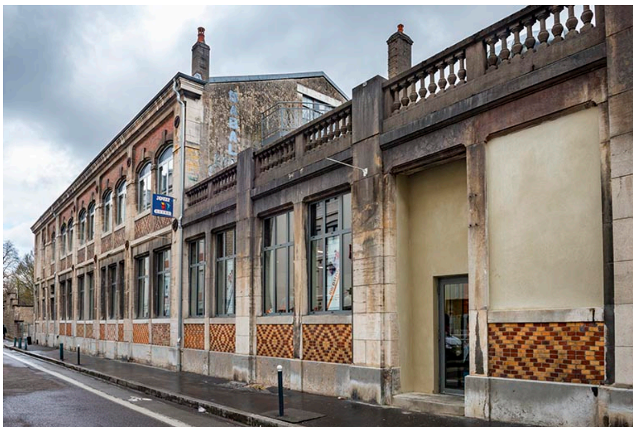
Vue rapprochée depuis le sud-ouest (après travaux).
