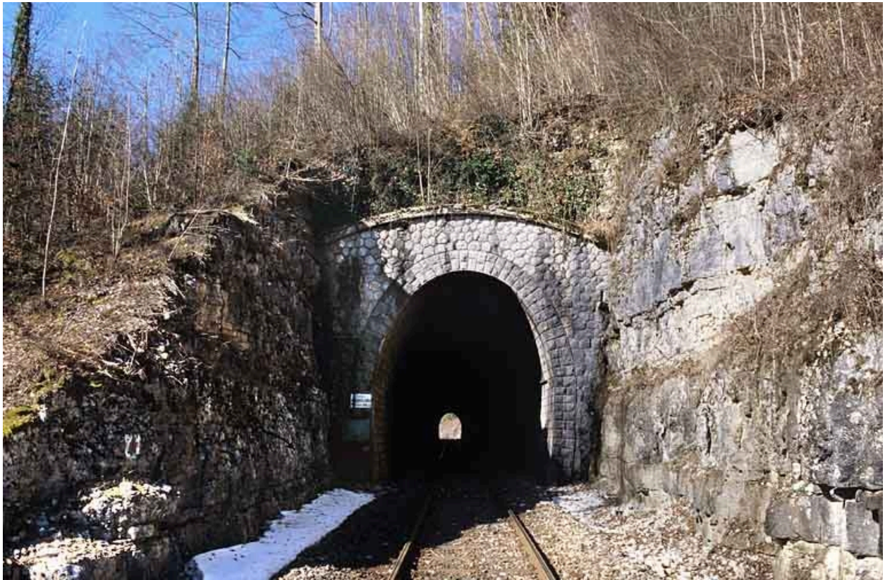
Tunnel des Bataillards : tête côté Andelot-en-Montagne (est).
