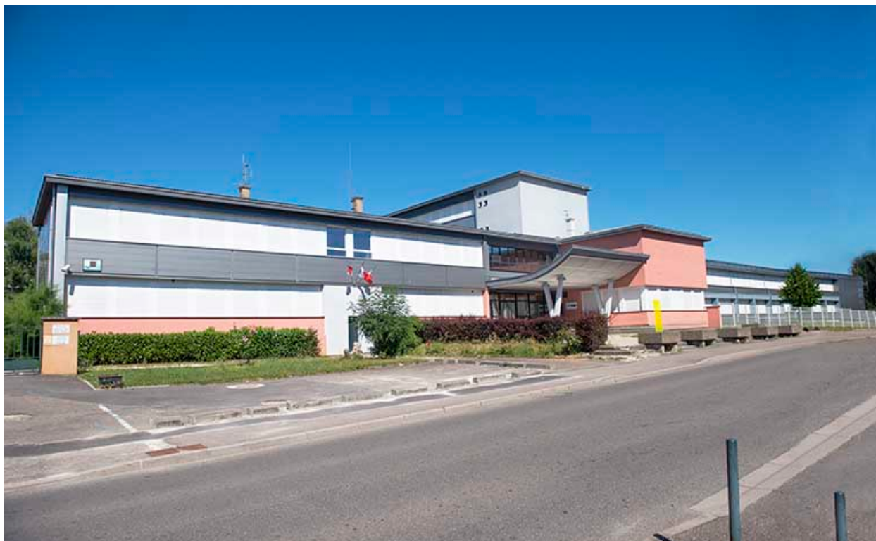
Façade antérieure sur rue.
