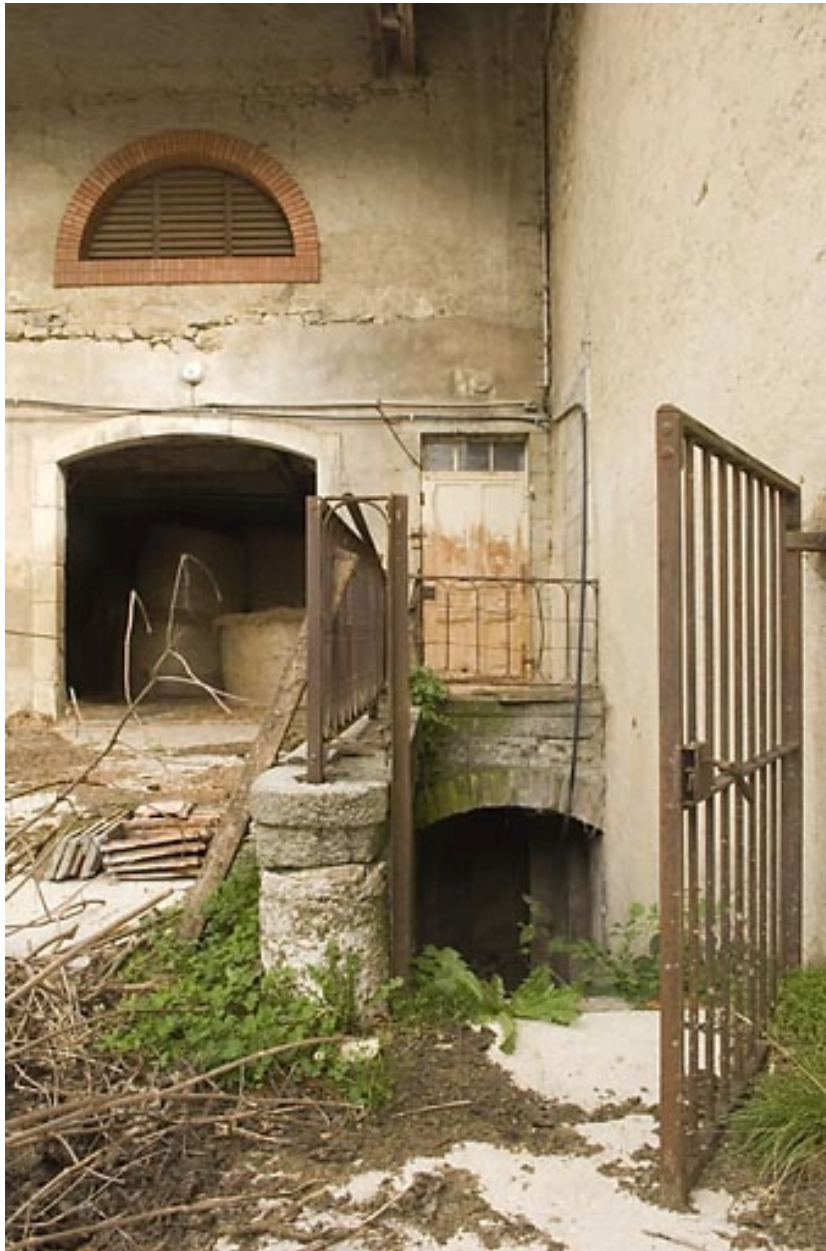
Habitation : façade postérieure, descente de cave.
